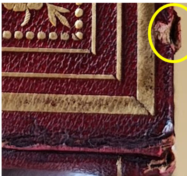
Figura 16 – Imagem macroscópica de dano no revestimento.
