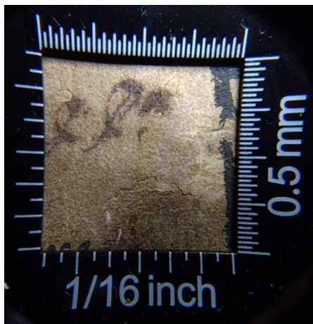
Figura 48 – Imagem capturada através da lente da lupa contafios, na qual se podem ser os halos ocasionados pela oxidação da tinta de base metálica.
