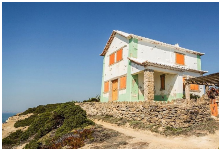
FIGURA 3 – Casa Branca em Azenhas do Mar, no litoral do município de Sintra. Construída em 1920, foi propriedade e residência de veraneio do próprio Lino.
